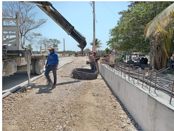
Elementos de delimitación y obra complementaria.
